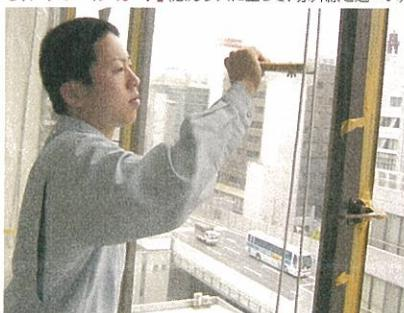
施工時に下の2つの溶剤を混ぜ合わせ、スポンジに染み込ませて塗る。約1時間で乾燥する。乾燥後は硬くなり、通常の接触や清掃などで損傷することはない。赤外線を92%カットする
