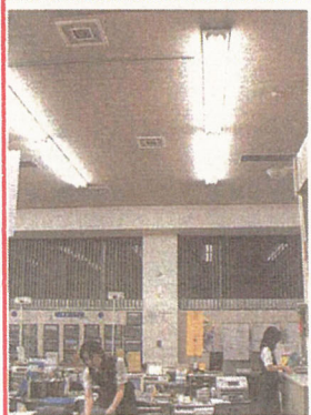
冷房病の予防に役立つ。天井にファンを取り付け、冷房温度を上げた宮城第一信用金庫本店営業部(青葉区中央)
